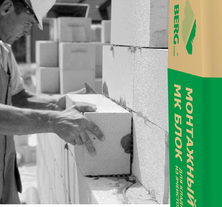
Универсальный клей для возведения кладок блоков из ячеистого бетона.
